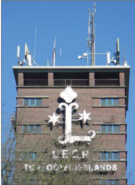
Auf dem Wasserturm in Leer wurde der Repeater installiert (Foto: Stadtwerke Leer)
