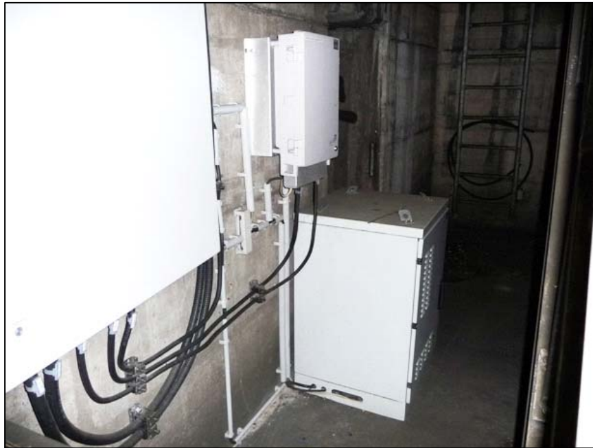
Streckenverstärker mit Einkoppelmöglichkeit für TETRA-BOS
