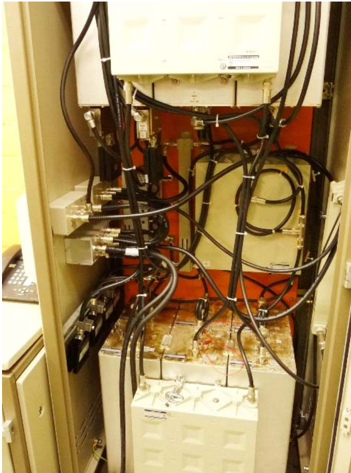
Einfügen in bestehendes Koppelnetzwerk
