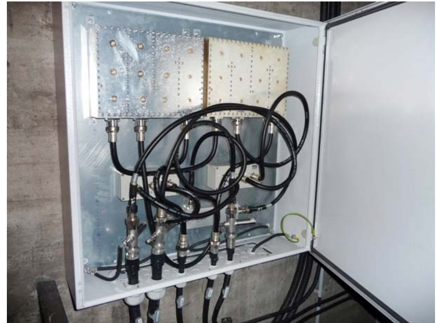
Streckenverstärker mit Einkoppelmöglichkeit für TETRA-BOS
