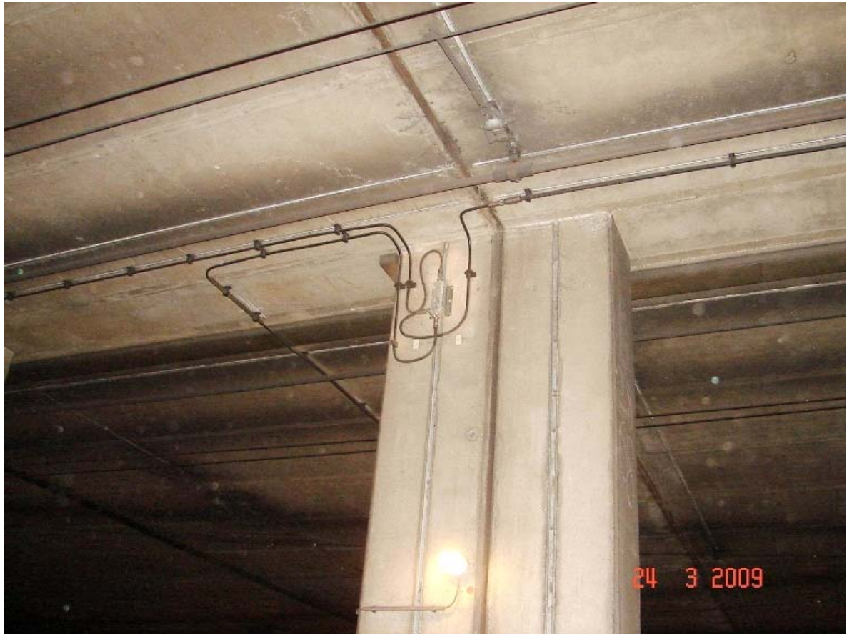
Austausch der Koppler im Gleisbereich gegen breitbandige Komponenten (2m + 70 cm)
