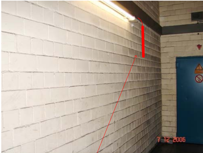
Omni-Antenne 2dBi senkrecht an Wand, hinter Lampe, in Schutzrohr.
